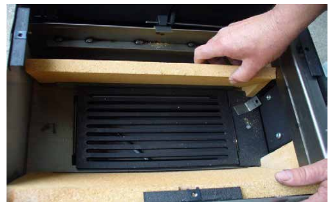
Wyjęcie szamotu bocznego od strony piekarnika
