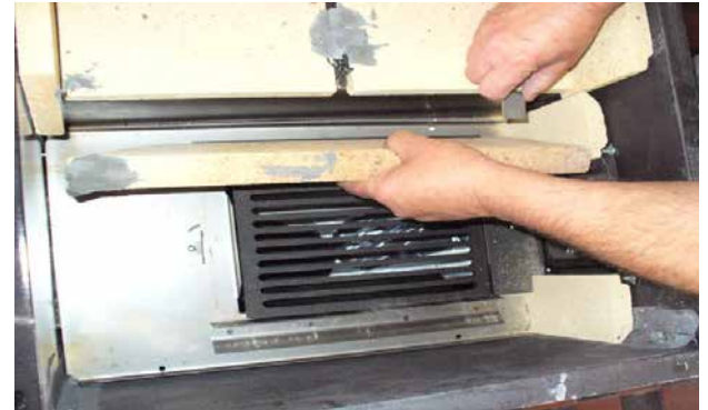
Wykręcenie śruby dolnego wkładu paleniska i jego wyjęcie
