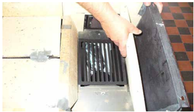
Wyjęcie szamotu bocznego od strony piekarnika
