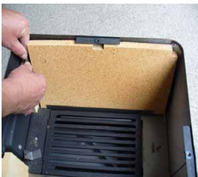
Wyjęcie bocznego szamotu po usunięciu blaszki mocującej
