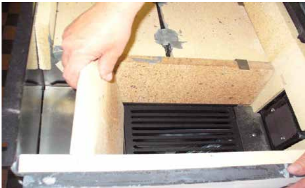
Wyjęcie szamotu nad drzwiami paleniska
