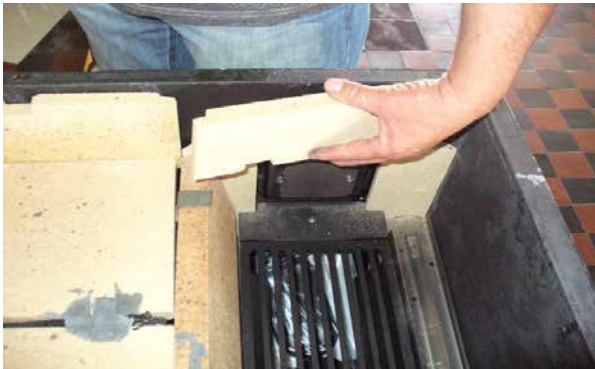
Wyjęcie bocznego szamotu po usunięciu blaszki mocującej
