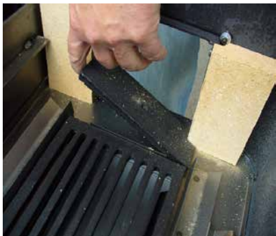
Wykręcenie śruby dolnego wkładu paleniska i jego wyjęcie
