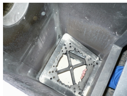
Wyjmowanie ramy rusztu
