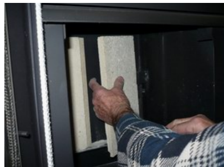
Wyjęcie tylnego wąskiego szamotu
