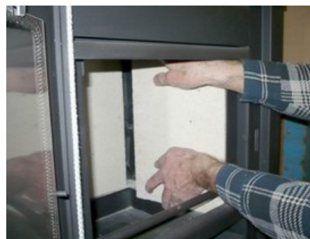
Wyjęcie dużego bocznego szamotu
